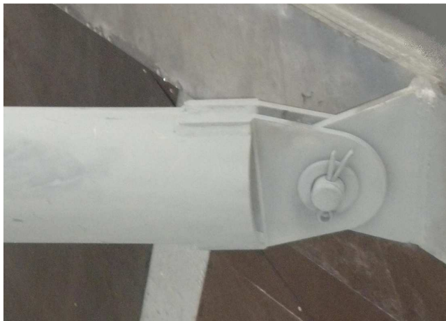
Figura 4.41: Exemplu de îmbinare cu bolț
